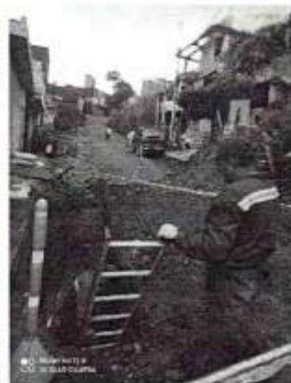
Descripción de la actividad: Se realiza el arreglo de la red de alcantarillado de 8' que baja por el sector debido a obstrucción y colapso de la misma.
