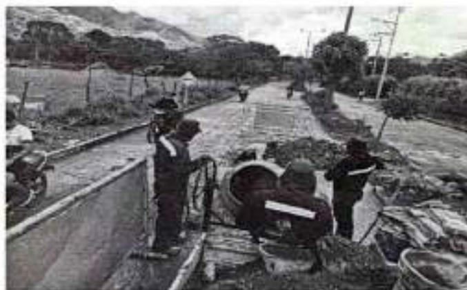
Descripción de la actividad: SE REALIZA ESTA ACTIVIDAD DEBIDO A QUE POR REPOSICIÓN DE RED DE ALCANTARILLADO QUEDO PENDIENTE LA REPOSICIÓN DEL PAVIMENTO.
