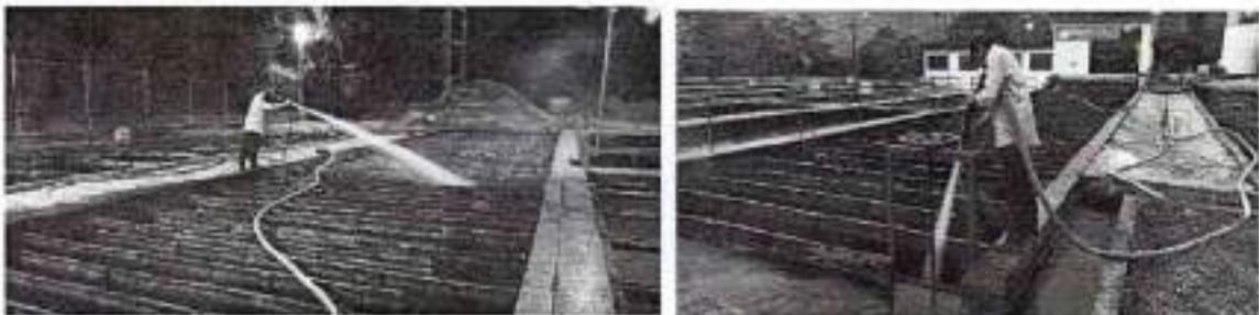
Descripción de la actividad: Periódicamente se realizan mantenimiento y lavado a las estructuras de la planta de tratamiento con el propósito de optimizar el sistema de captación, conducción, y potabilización del agua, realiza mantenimientos preventivos y correctivos periódicamente sobre todo el sistema de acueducto.
