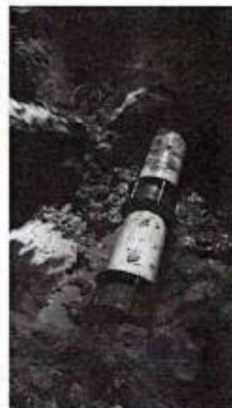
Descripción de la actividad: Se realiza el arreglo en la red de 16" debido a daño con maquinaria en la obra del canal que se entra construyendo en el barrio bella vista
