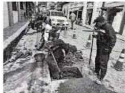
ACTIVIDAD: Se realizan reparaciones de fugas en diferentes sectores del municipio de la plata debido a daños en las redes de acueducto generalmente las que son de asbesto.
