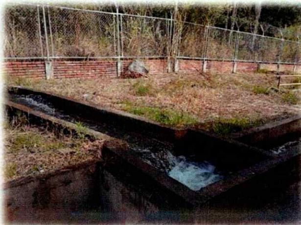
En este punto el operador de turno debe tomar muestras para realizar la prueba de jarras en el laboratorio, la cual indica la cantidad necesaria de químico coagulante necesario para formar el floc en el agua. El punto donde se adiciona el coagulante (MACKENFLOC II) se denomina punto de mezcla rápida.
