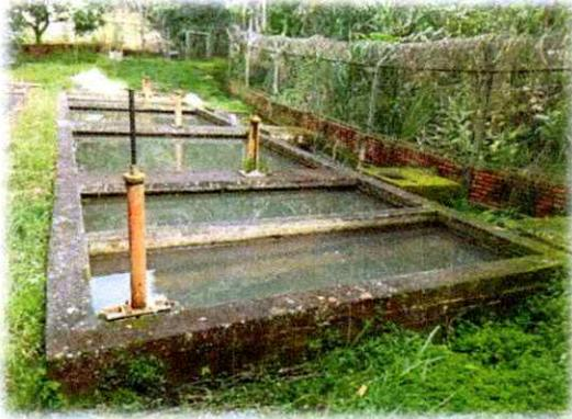
Foto 4 Desarenador de flujo vertical
