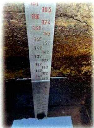
Ilustración 9 Dosificación del coagulante
